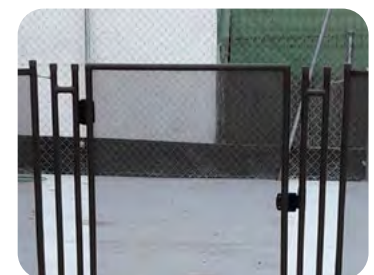
Πόρτα με αυτόματο κλείσιμο. Άνοιγμα πάντα προς τα έξω & να κλειδώνει πάντα προς την πισίνα. Automatic self closing gate. Opening always towards the outside & lock towards the pool.
