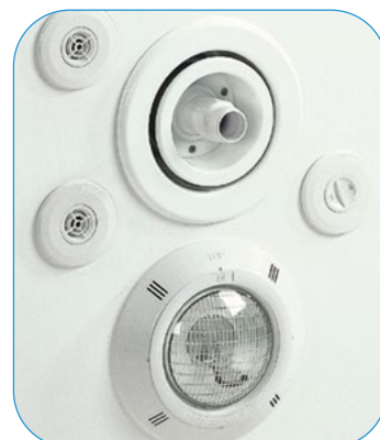
Φωτιστικό και σύστημα αντίθετης κολύμψης Spotlight and jet stream
